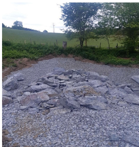
Těleso přehrážky v ř.km 1,830
