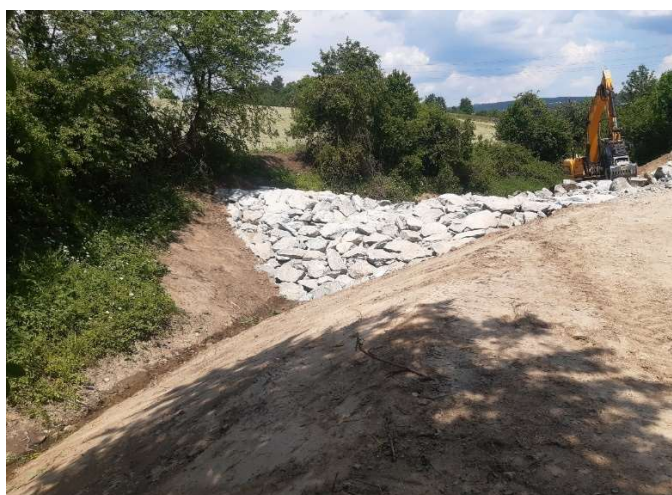
Těleso přehrážky v ř.km 1,890
