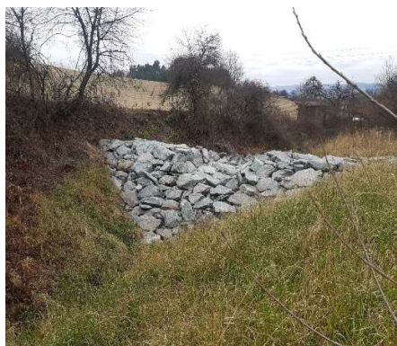
Přehrážka v ř.km 1,890
