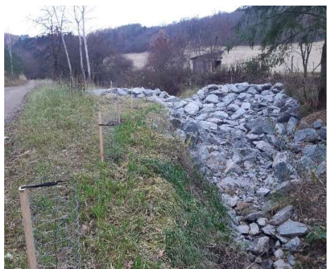
Přehrážka v ř.km 1,830
