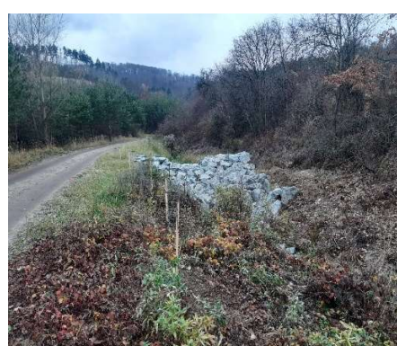
Přehrážka v ř.km 1,955
